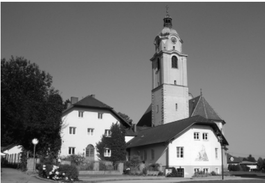
Im Pfarrhof (links) ist die Wohnung des Pfarrers bzw. der Pastoralassistentin untergebracht, der Pfarrsaal (rechts) ist Teil des Pfarrzentrums.
